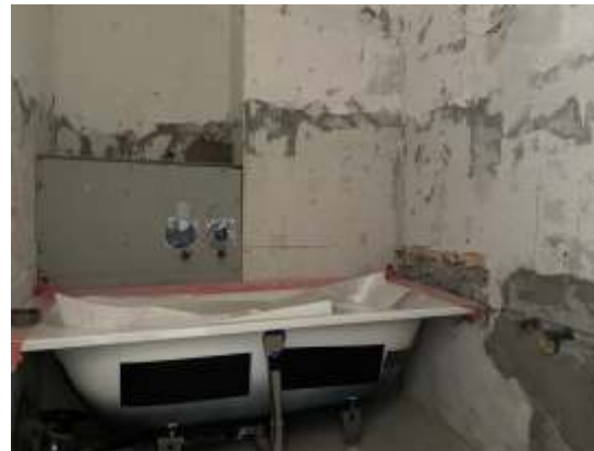
während dem Umbau
